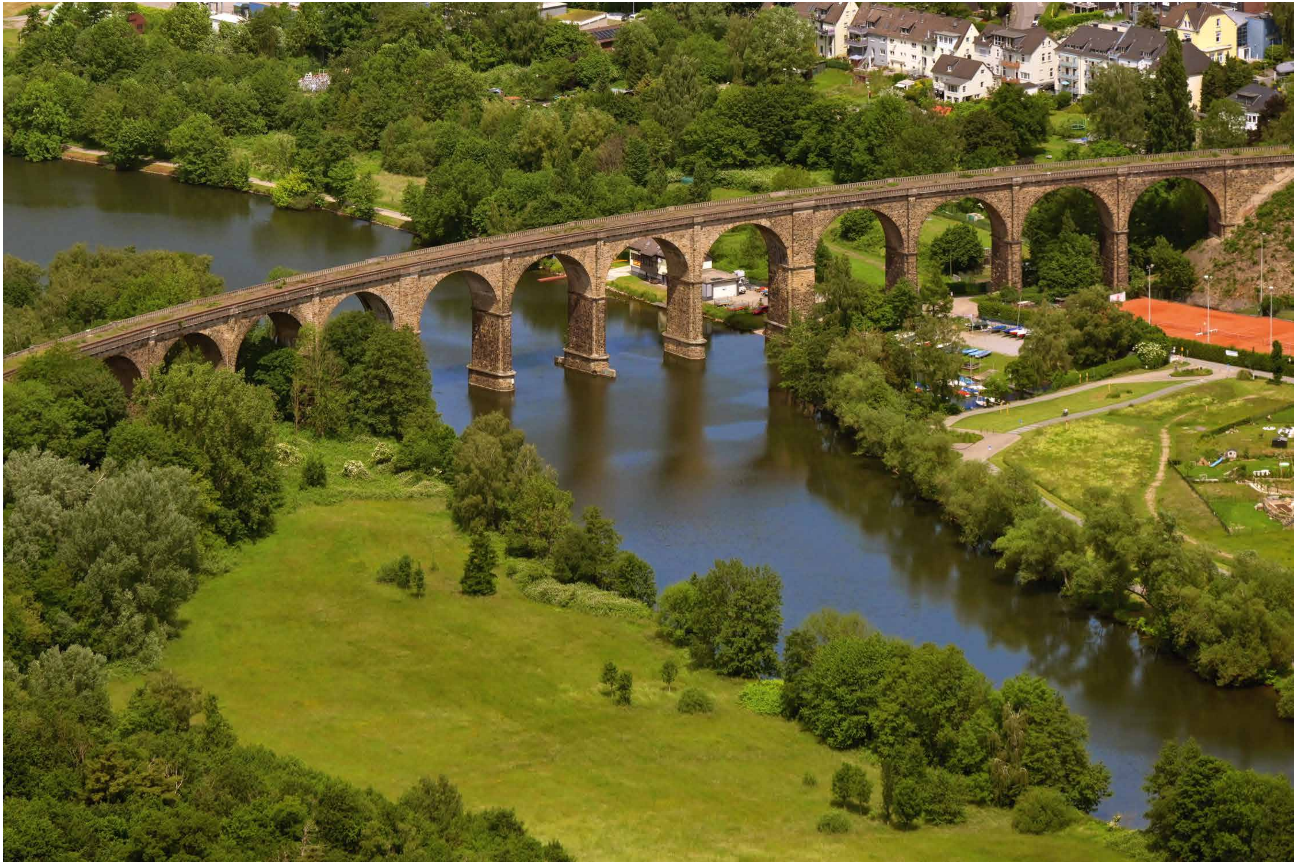
Der Ruhr-Viadukt bei Herdecke
